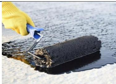
Deverá ser executada impermeabilização de baldrame através da aplicação de membrana asfáltica líquida em todas as suas faces externas.
