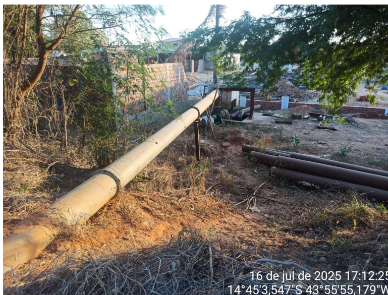
6. VISTA DO DIQUE
