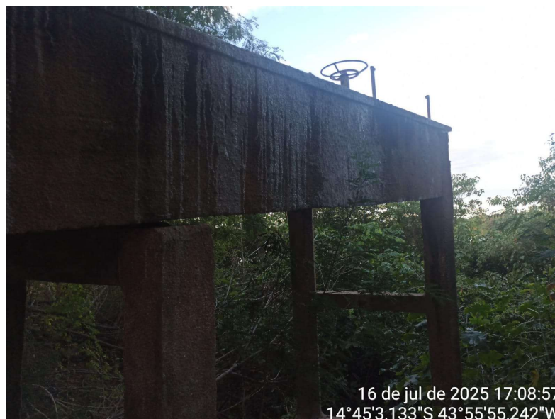
2. ESTRUTURA A SER DEMOLIDA
