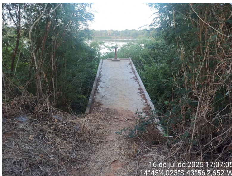
1. ESTRUTURA DA COMPORTA A SER DEMOLIDA
