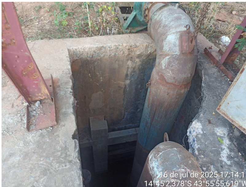
5. CAIXA DE PASSAGEM EXISTENTE, INÍCIO REDE TUBULAR
