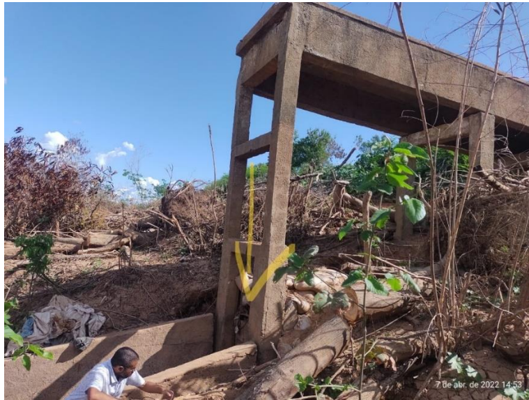
Estrutura da comporta a ser demolida
