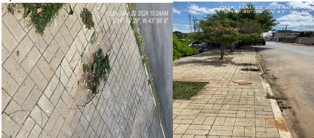
Foto 1 – Canteiros e Meio Fio a ser feito Limpeza
