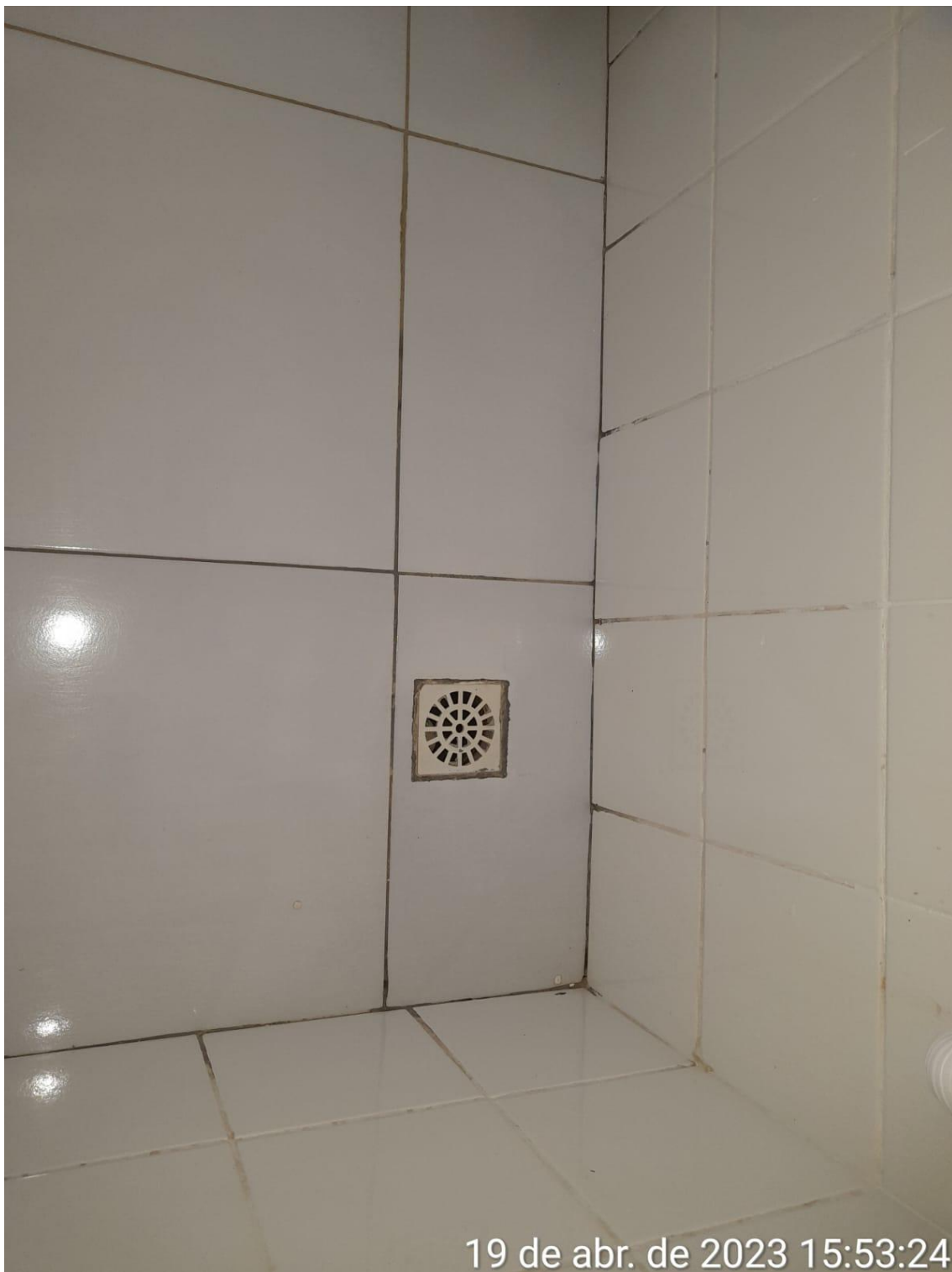
Foto 02 Substituição do ralo
