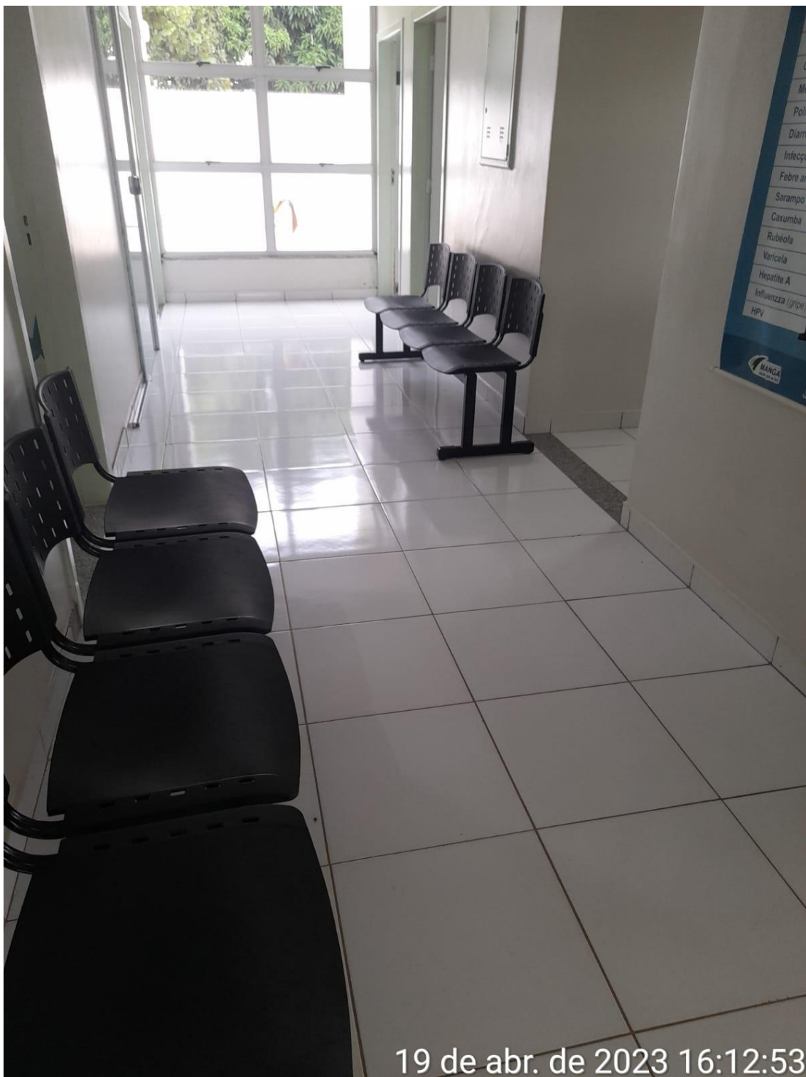
Foto 15 troca de Piso
